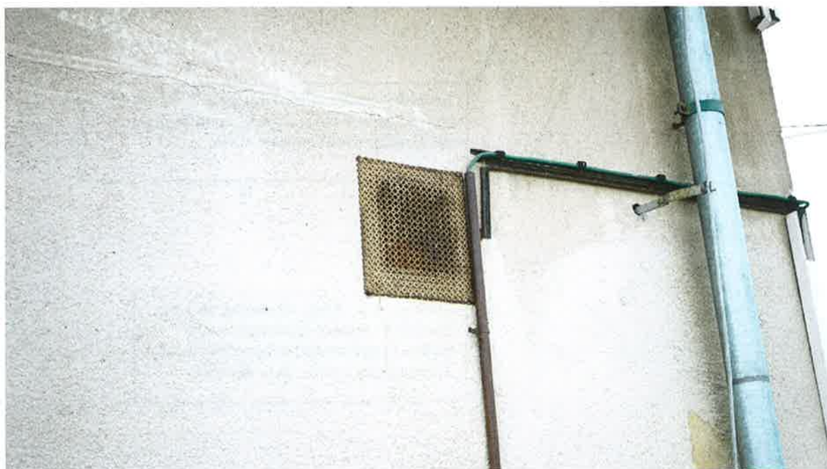
Obr. 2: odvětrávací otvory obvodové konstrukce jsou osazeny mřížkami
