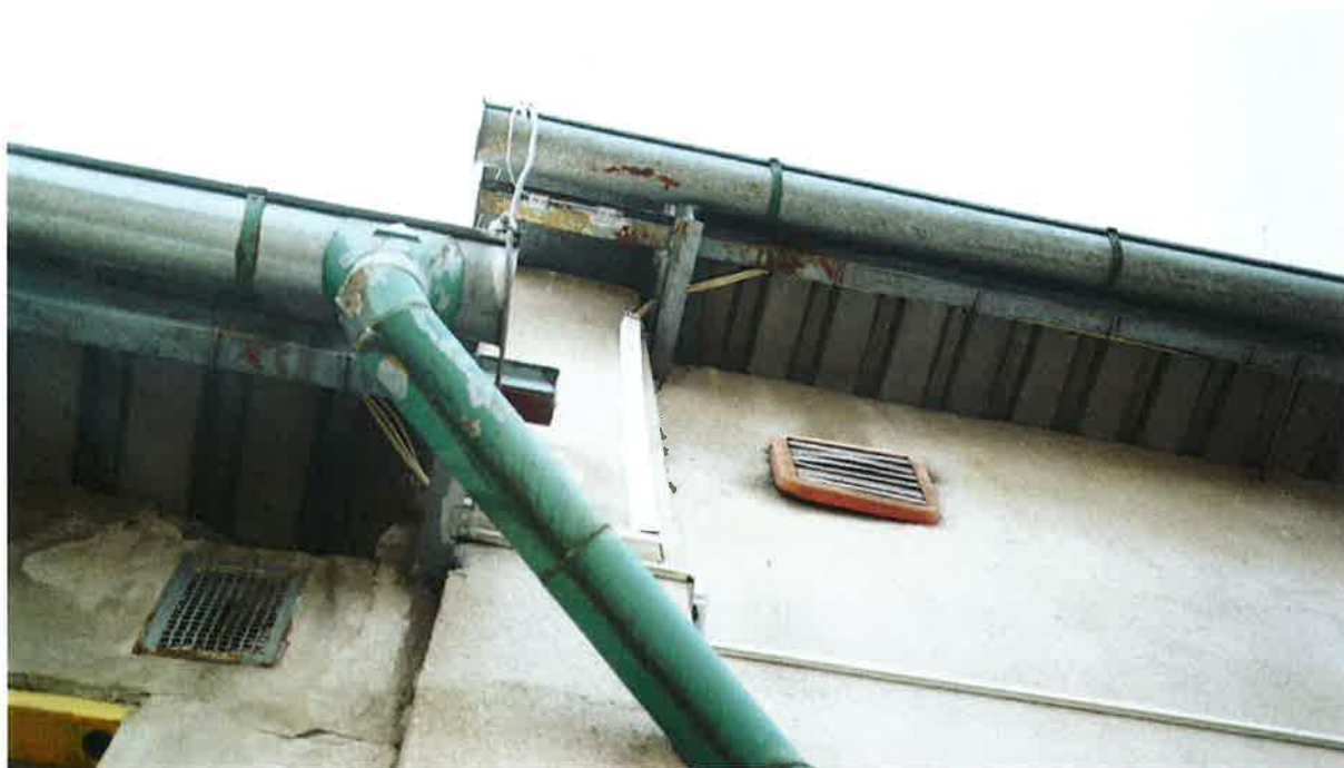
Obr. 3: lety poškozená vnější konstrukce nabízí mnoho štěrbin a dutin pro ptáky a další živočichy
