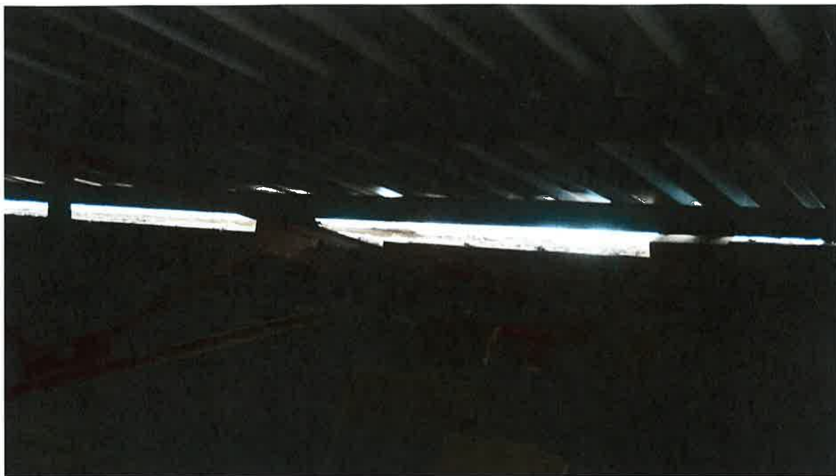
Obr. 1: podstřešní prostory jsou volně dostupné pro živočichy díky množství spár a štěrbin
